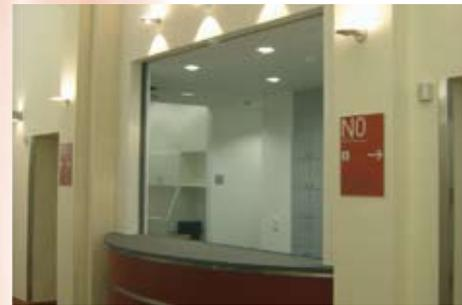
Feuerschutzabschluss Fibershield P
